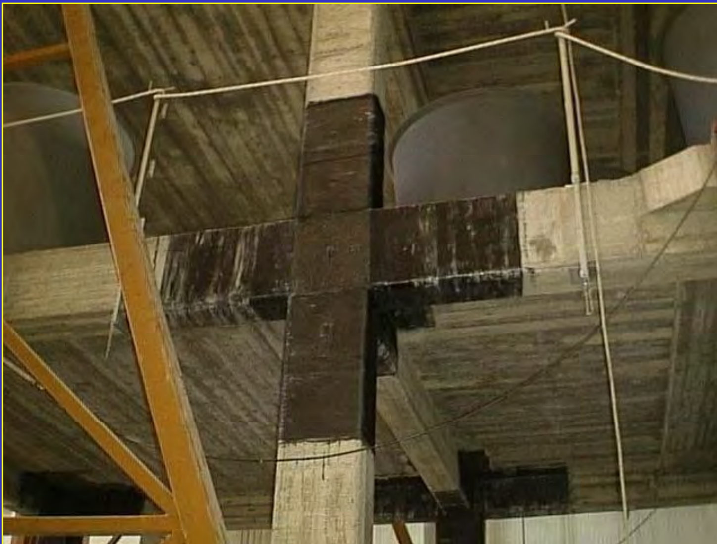
rinforzo con CFRP del nodo trave-pilastro : vista d'insieme finale
