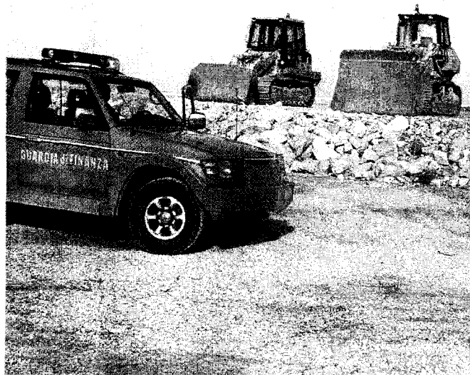
Il cantiere per il rigassificatore di Brindisi. A dieci anni dall'avvio dell'iter autorizzativo e nonostante i 200 milioni investiti è fermo e sotto sequestro
