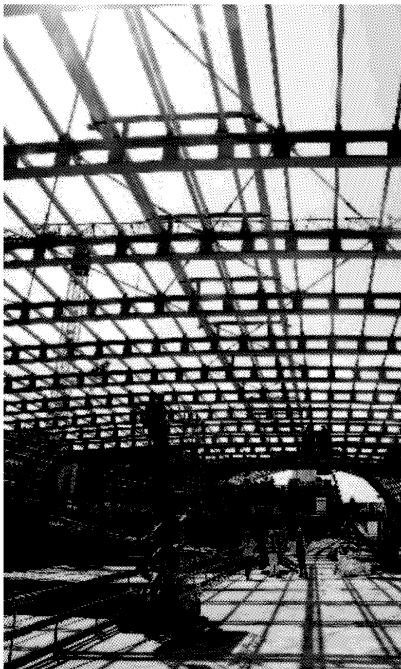
Lavori in corso. La stazione alta velocità di Torino Porta Susa
