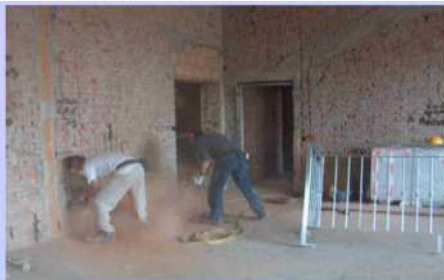
Esecuzione taglio e svuotamento traccia su mattoni pieni
