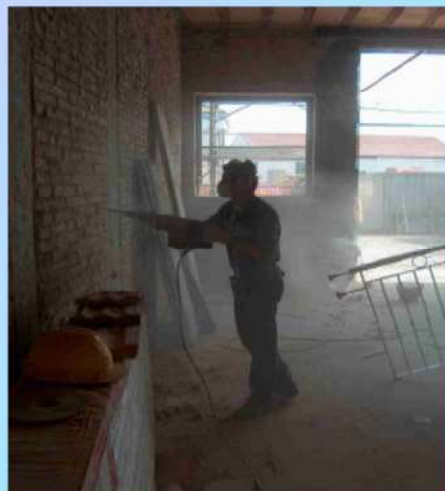
Svuotamento traccia su mattoni pieni con martello percussore
