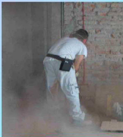
Esecuzione taglio e svuotamento traccia su mattoni pieni
