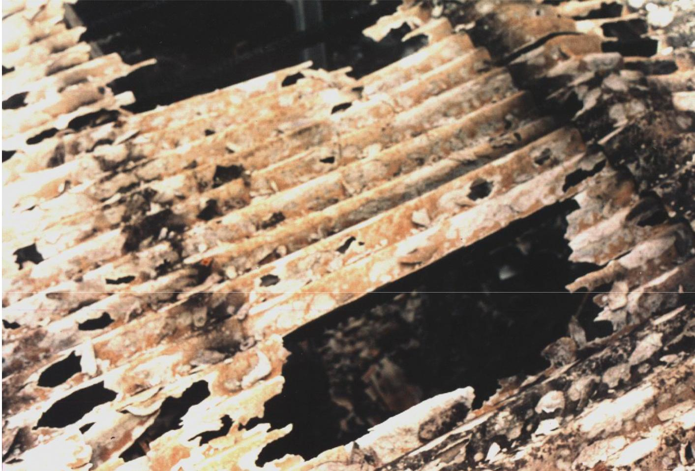
**In caso di incendio si evidenzia come il cemento si sfaldi e perda le sue proprietà di resistenza e di tenuta dove la temperatura raggiunge valori elevati si evidenzia le lastre si rompono e tendono a sfaldarsi in pezzi che ricadono sulle coperture adiacenti**
