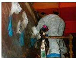
Figura 54 - Rimozione del materiale contaminato
