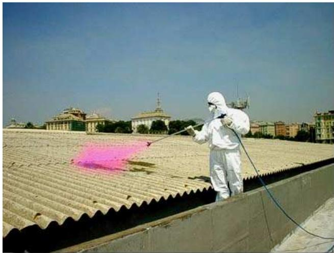
**Figura 60 - Bagnatura del cemento-amianto**
