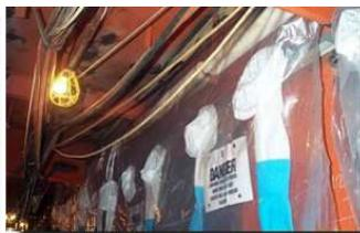
Figura 51 - Isolamento della zona con Glove-Bag
