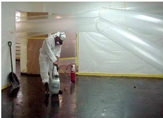
Figura 20 - Confinamento statico e dinamico
