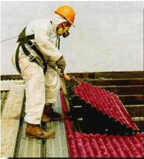
Figura 15 – Rimozione lastre in eternit
