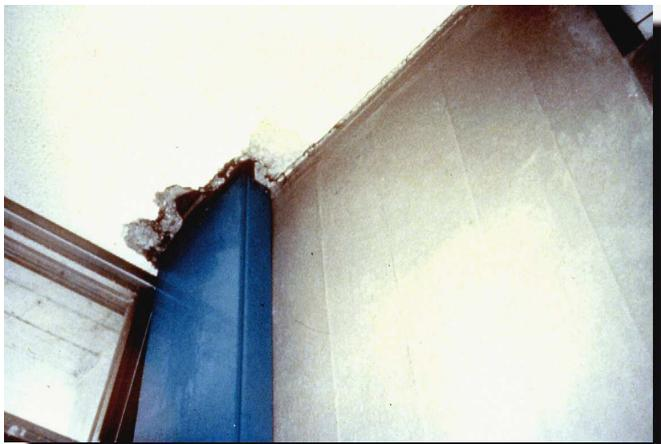
Figura 13 – Degrado spontaneo di solaio contenente amianto
