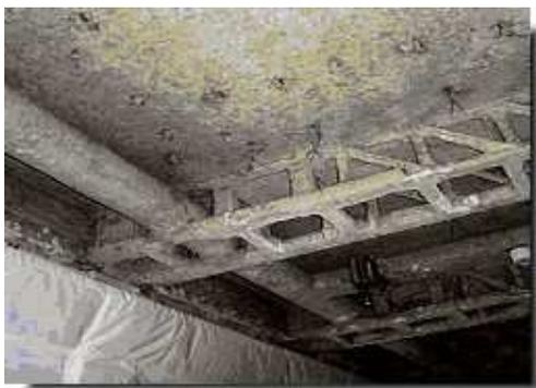
**Figura 11 - Amianto friabile spruzzato nelle strutture metalliche di un edificio**
