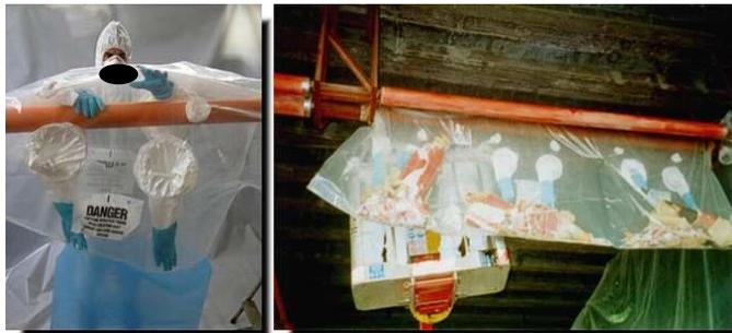
Figura 49 - Tecnica del Glove-Bag
