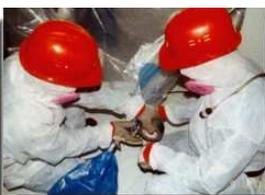
Figura 56 - Sigillatura del sacco con nastro
