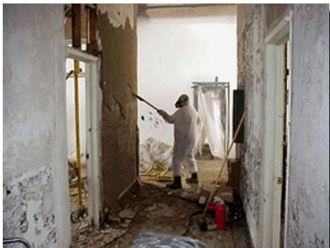
Figura 26 - Rimozione rivestimento dopo il trattamento
