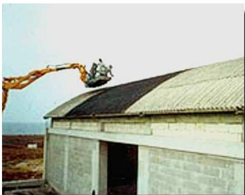
Figura 61 - Posa della sovracopertura
