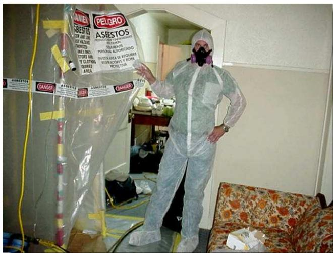
Fig. 43 - Sistema di confinamento in polietilene e telaio in elementi tubolari
