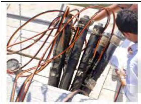
Fig. 33 Fase di tesatura di un tirante di prova Fig. 33 Load Test Operations
