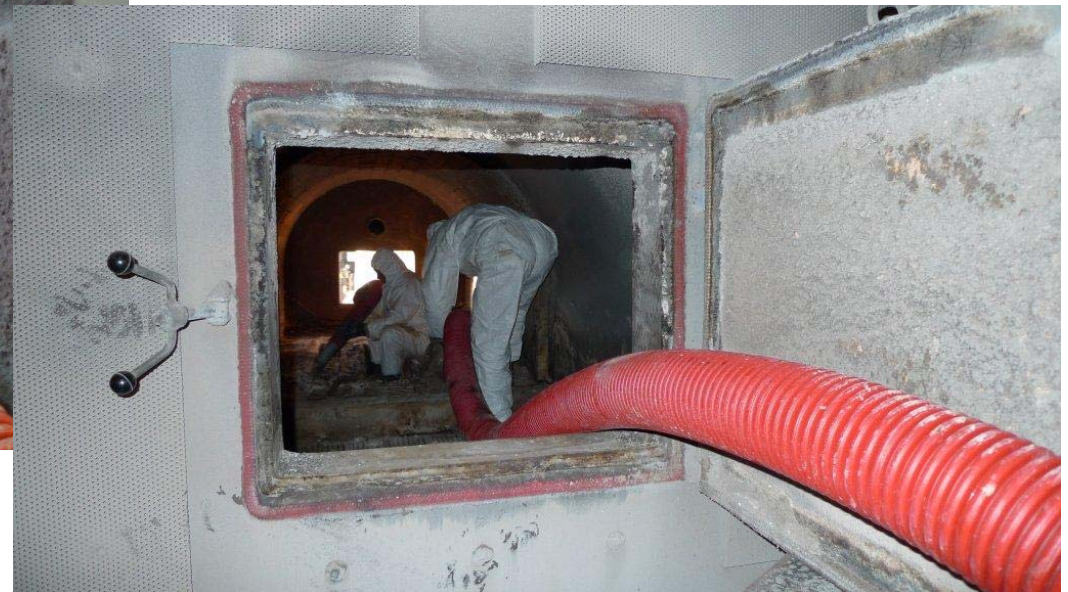
ESEMPI DI FASI LAVORATIVE IN AC
