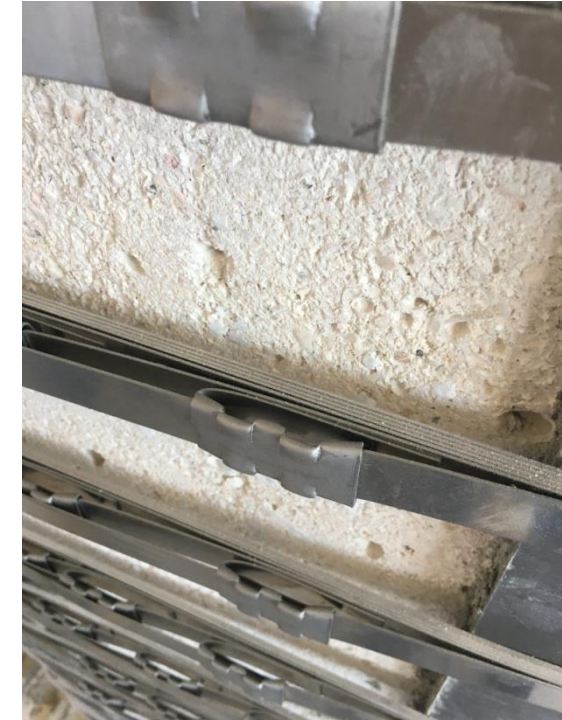
Figura 8. Sistema CAM su strutture in c.a..
