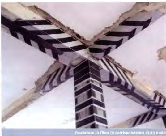
Fasciature in fibra in corrispondenza di un nodo
