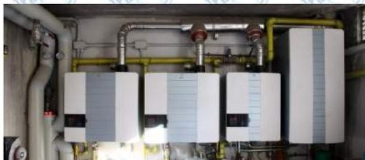
impianti gas ad uso extradomestico collegati ad apparecchi con portata termica nominale massima > 35 kW
