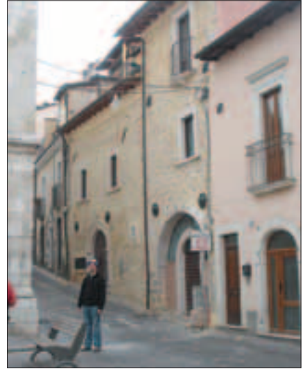
Fabbricato in muratura a sacco recentemente consolidato nel centro storico.
