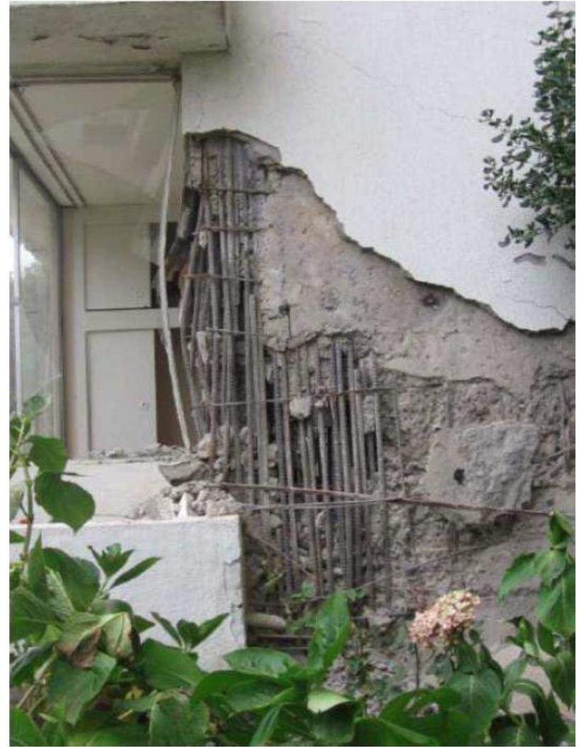
Instabilità delle armature e disgregazione del nucleo di calcestruzzo
