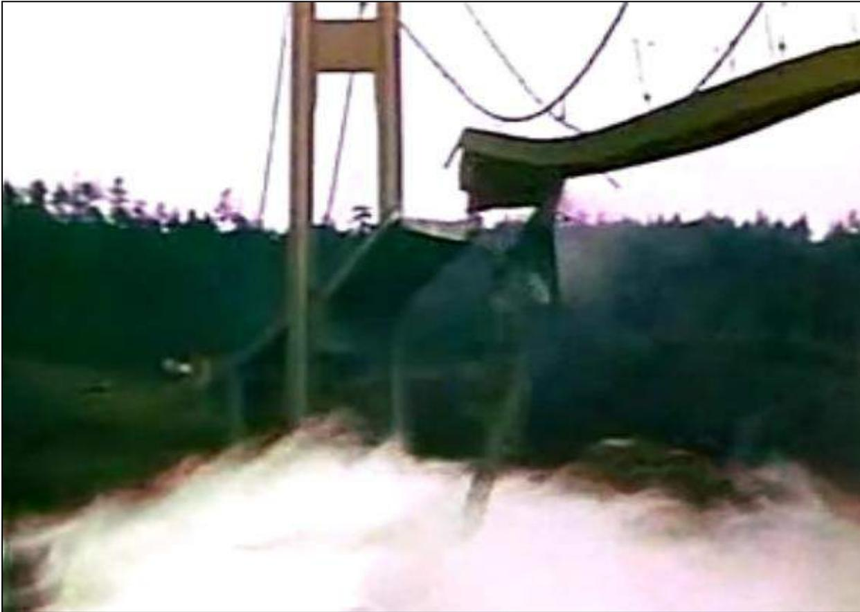
Oscillazioni forzate indotte da un **vento di 70 km/h** per **distacco regolare di vortici** a frequenza pari a quella di oscillazione verticale e torsionale
