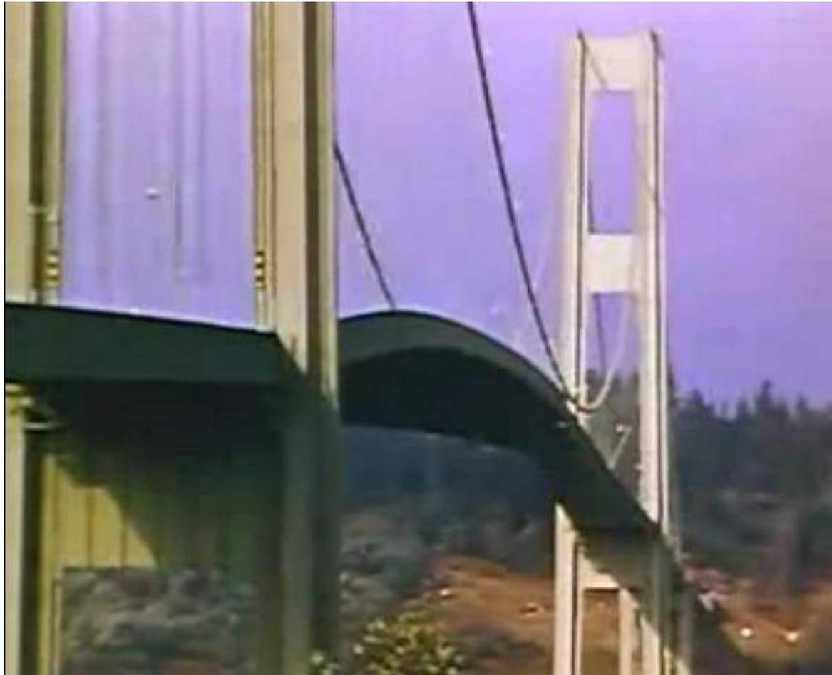
Oscillazioni forzate indotte da un **vento di 70 km/h** per **distacco regolare di vortici** a frequenza pari a quella di oscillazione verticale e torsionale
