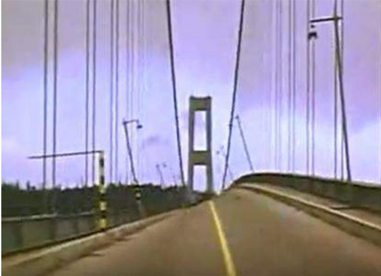
Oscillazioni forzate indotte da un **vento di 70 km/h** per **distacco regolare di vortici** a frequenza pari a quella di oscillazione verticale e torsionale
