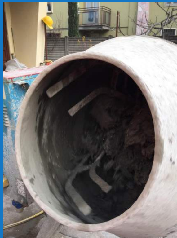
Miscelazione in betoniera
