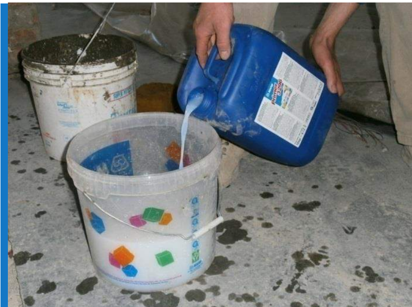
Consolidamento della superficie con PRIMER 3296
