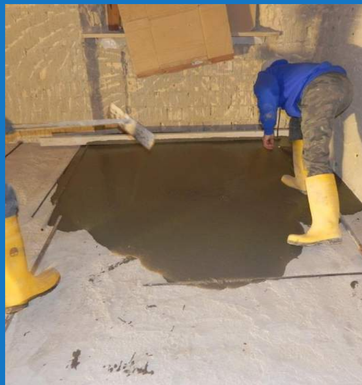
Getto di PLANITOP HPC FLOOR
