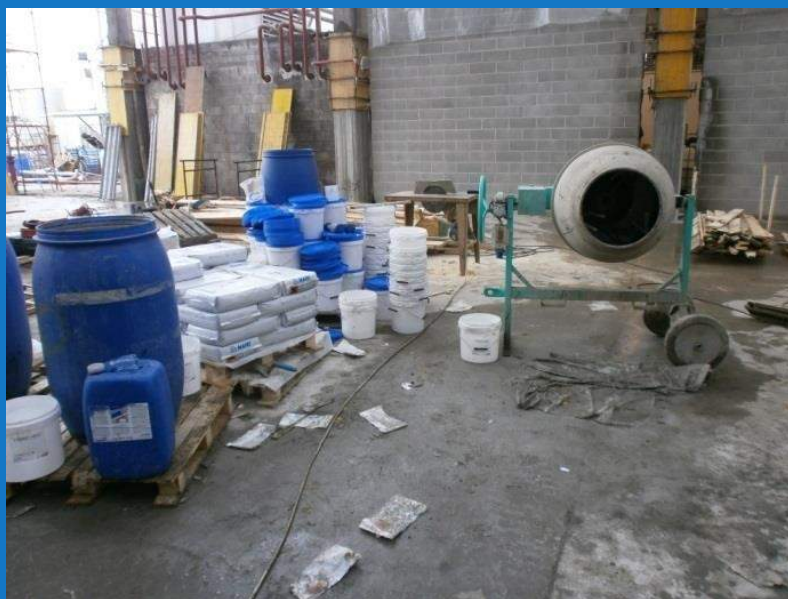
Miscelazione PLANITOP HPC + FIBRE HPC
