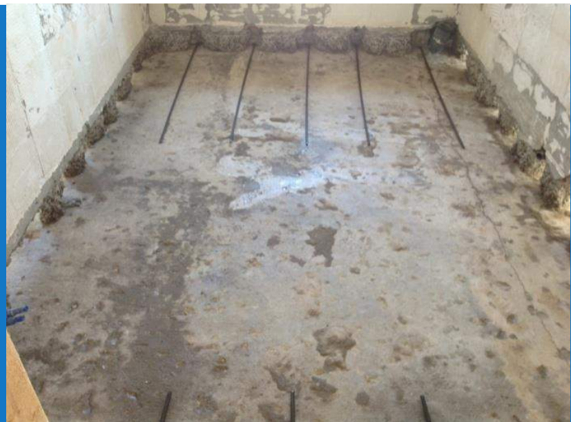
Preparazione del supporto
