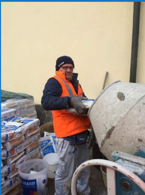
Miscelazione in betoniera
