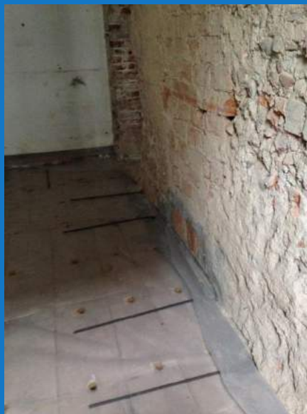
Realizzazione di connessioni perimetrali
