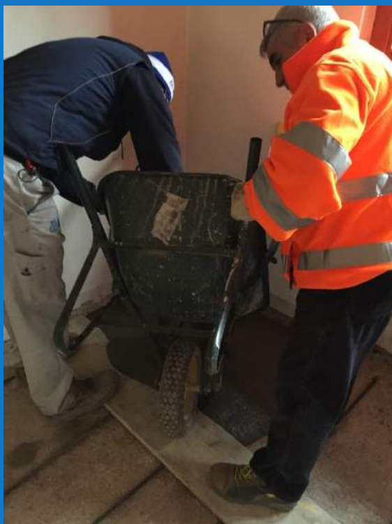
Getto di PLANITOP HPC FLOOR
