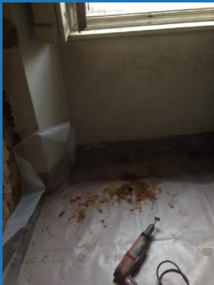
Realizzazione di fori In corrispondenza dei travetti in legno
