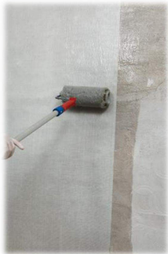
Applicazione del secondo strato MAPEWRAP EQ ADHESIVE
