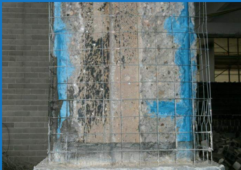
Preparazione del supporto
