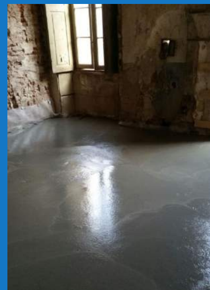
Applicazione di PLANITOP HPC FLOOR
