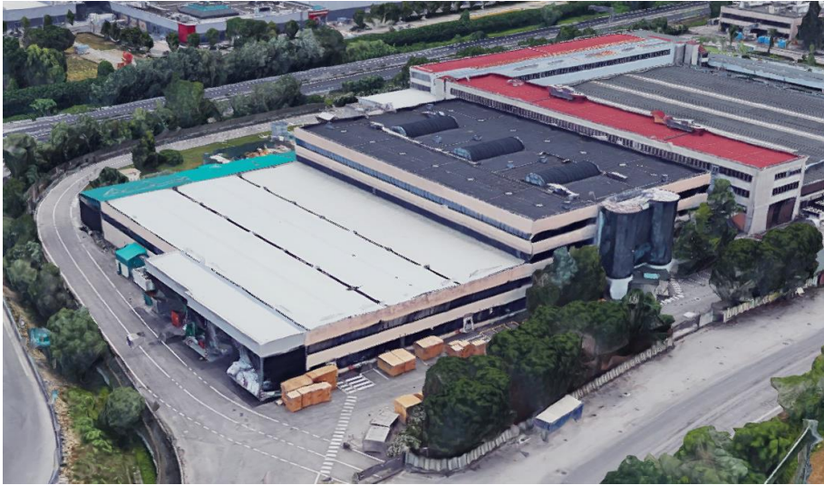
Corpo del fabbricato (Google Maps)
