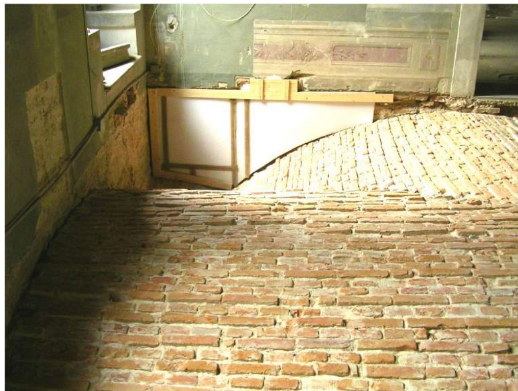
Dettaglio dell'estradosso della volta
