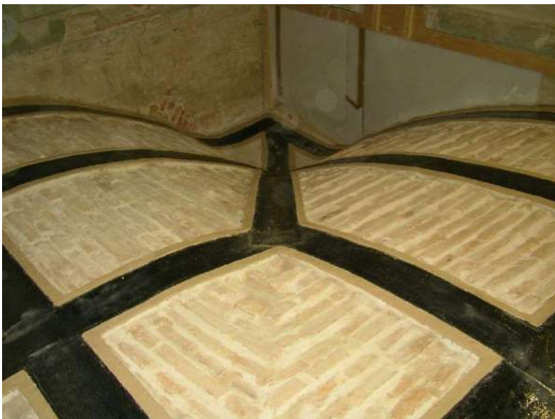
Dettaglio dell'imposta della volta
