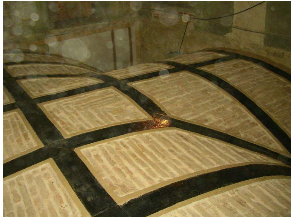
Vista dell'estradosso della volta
