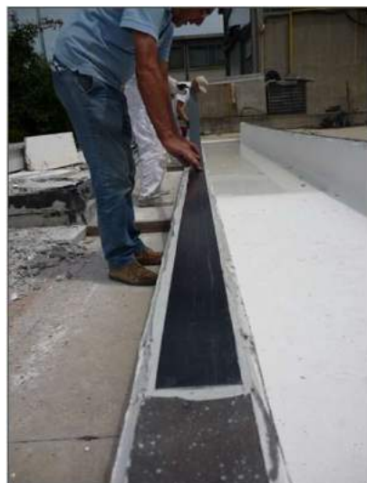
TT02 - RINFORZO CON LAMELLA CFK IN CARBONIO E ADESIVO RESIN 90
