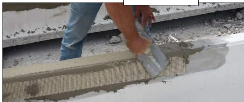
TT02 - RINFORZO CON LAMELLA CFK IN CARBONIO E ADESIVO RESIN 90
