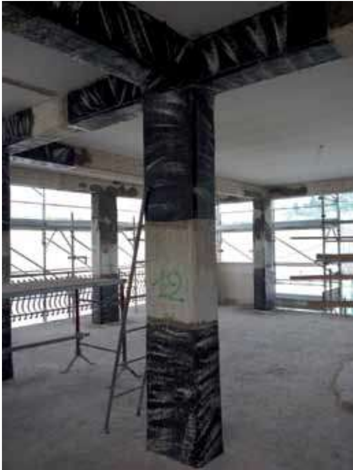
Rinforzo nodo trave-pilastro L'Aquila
