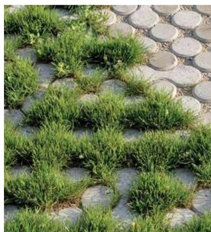
L'utilizzo di diverse tipologie di pavimentazioni drenanti può trasformare radicalmente l'aspetto di un parcheggio, rendendolo più interessante e dinamico creando un'alternanza visiva che rompe la monotonia dei parcheggi tradizionali.
