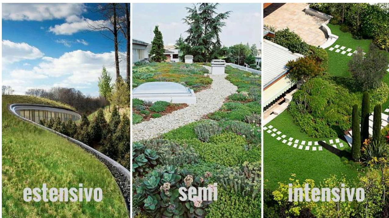
I vantaggi delle coperture verdi sono:
