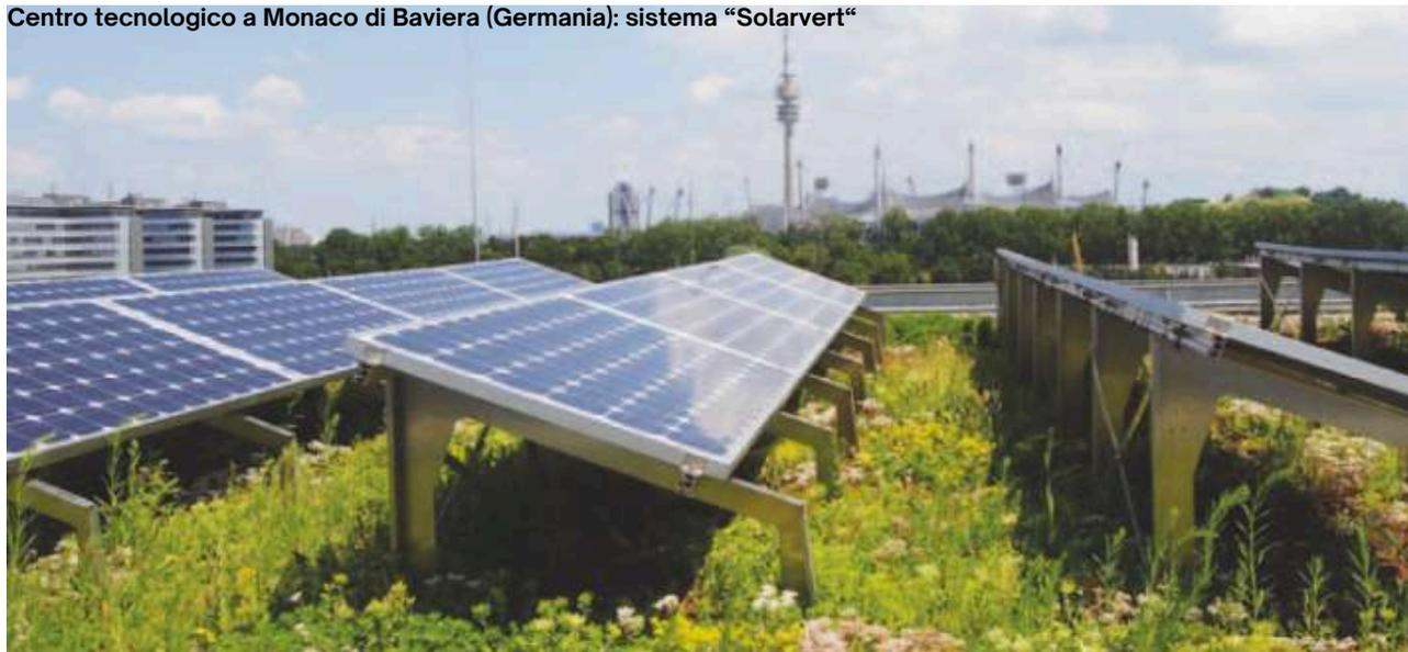
Il risultato finale è un sistema capace di produrre energia e, allo stesso tempo, fornire importanti benefici combinando i fattori del tetto verde a quelli dell’impianto fotovoltaico.
